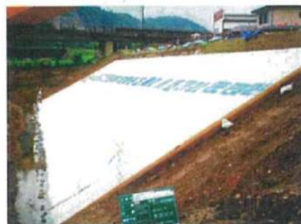
底部做护坡墙 铺土工布
