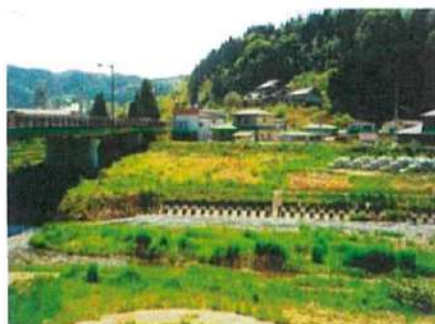
施工前原土护堤
