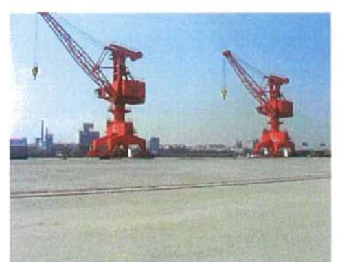
铺设完成效果图
