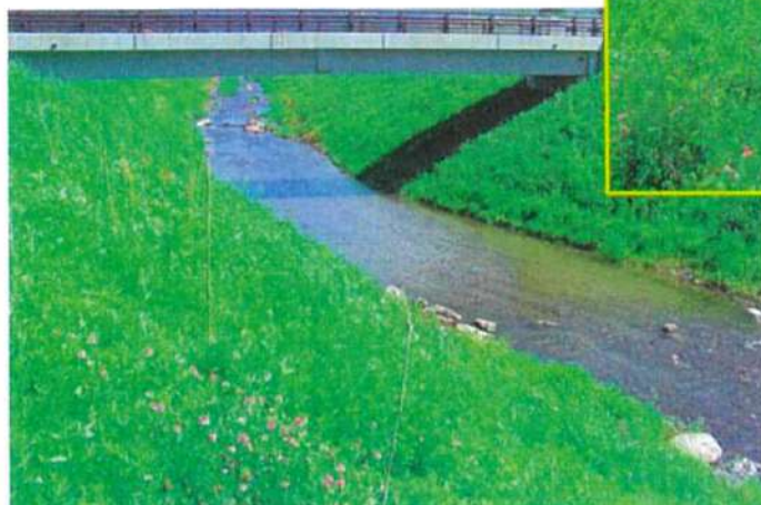
施工完毕两年绿化情况
