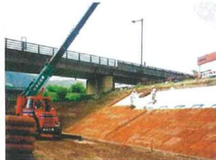
铺砌绿化透水砖 水泥砂浆填缝
