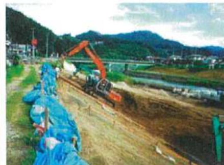
施工坡面整平
