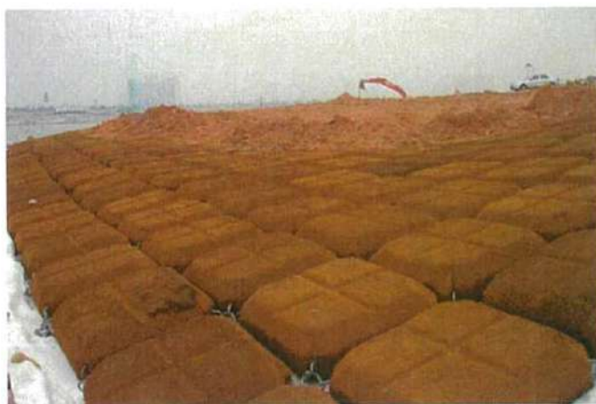
深圳F1赛艇基地施工中
