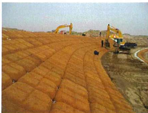
佛山新城区施工中
