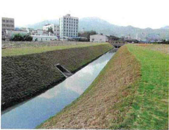
珠海北山村施工后
