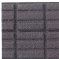
目地入れ前状態
